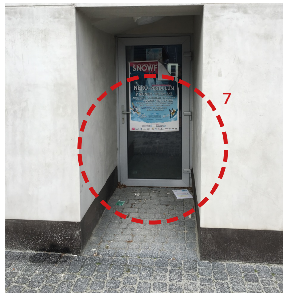
wejście do pomieszczeń pod widownią
